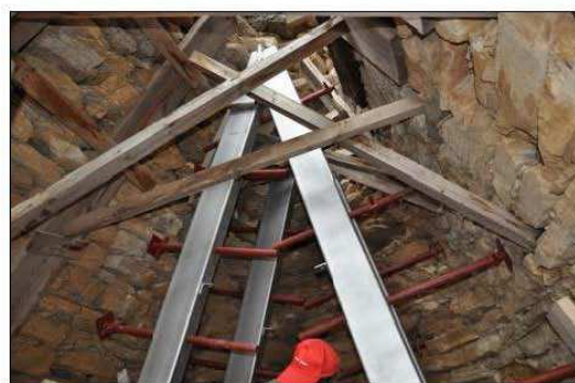
Φωτ. 16: Θολωτός τάφος IV. Κατά τις εργασίες τοποθέτησης του μεταλλικού κριώματος. [ Αρχείο ΔΑΑΜ 2010 ]
