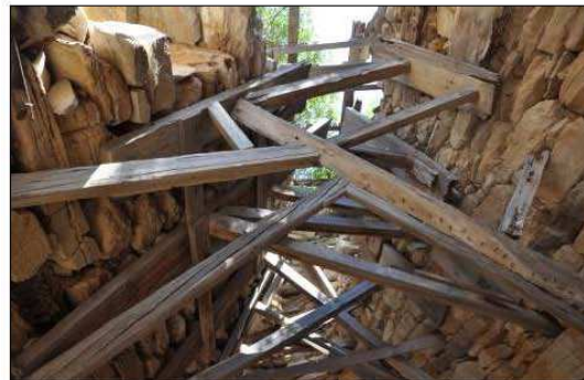
Φωτ. 14: Θολωτός τάφος IV. Πριν την τοποθέτηση μεταλλικού κριώματος αντιστήριξης. [ Αρχείο ΔΑΑΜ 2009 ]
