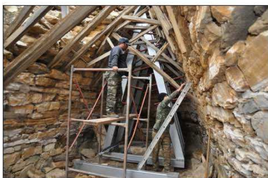
Φωτ. 15: Θολωτός τάφος IV. Κατά τις εργασίες τοποθέτησης του μεταλλικού κριώματος. [ Αρχείο ΔΑΑΜ 2010 ]
