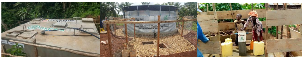
Figure 01 Réservoir en Béton Armé avec la capacité de 100 m3 de stockage avant pompe, F02_Réservoir métallique de 70 m3 pour le réseau de distribution avec 24 robinets, F03 Une bénéficiaire à la Borne Fontaine avec bénéficiaires.
