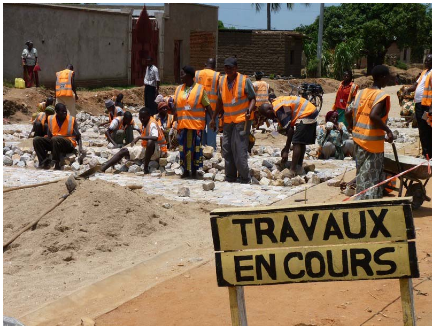
Apprentissages sur chantiers écoles © Rosalie Colfs/programme pavage/ CTB
