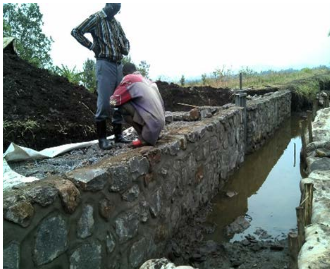
Photo 1 : Travaux de remise en fonction des canaux
