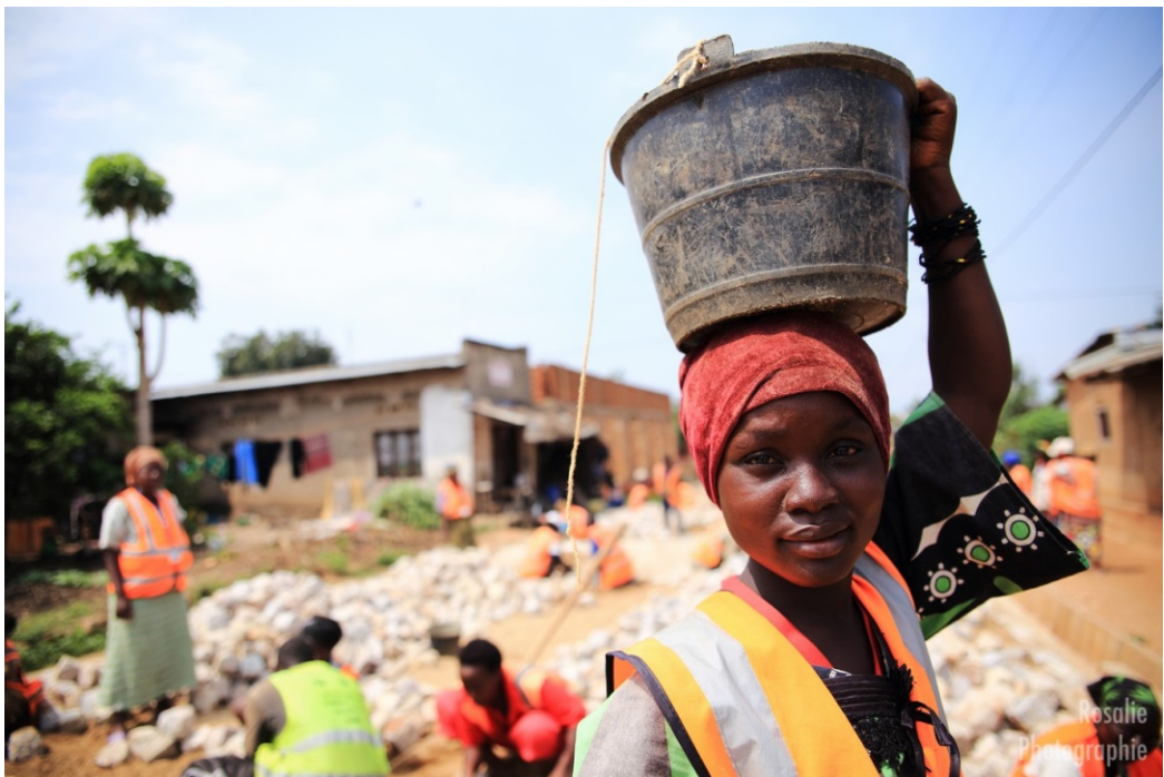
Apprentissages sur chantiers écoles à Kamenge © CTB/programme pavage/Rosalie Colfs
