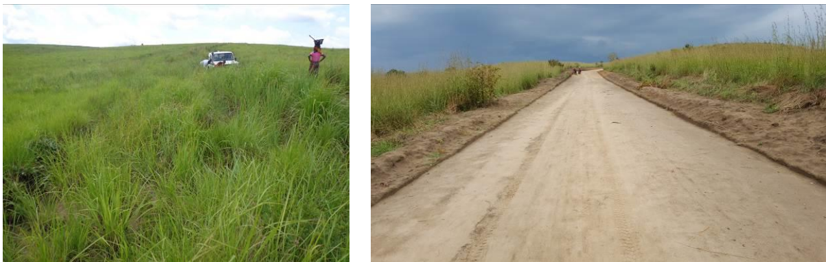
Travaux de réouverture de l'axe Village Mutselenge / Bac Kitona / Route de Feshi exécuté par des PME.
