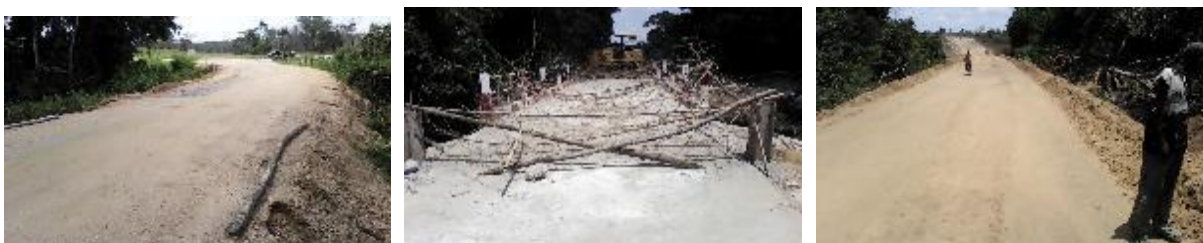
Première phase digue Ndana
