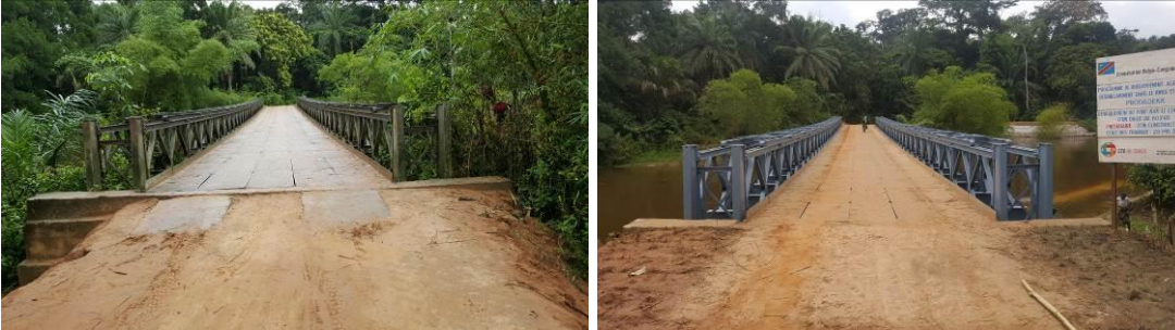
Situation du pont Kafy avant et après réhabilitation.
