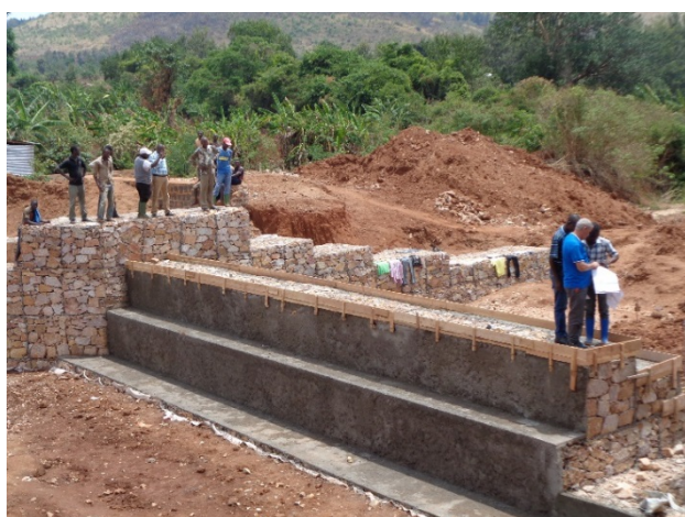
Photo 6 : Barrage Musasa 3 en réhabilitation
