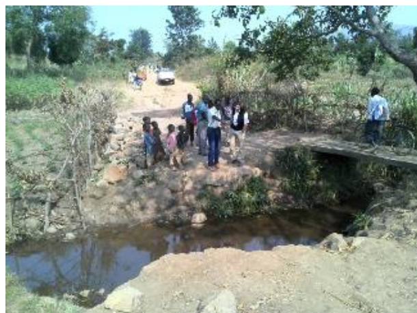
Photo 8 : Pont Mago (avant)
