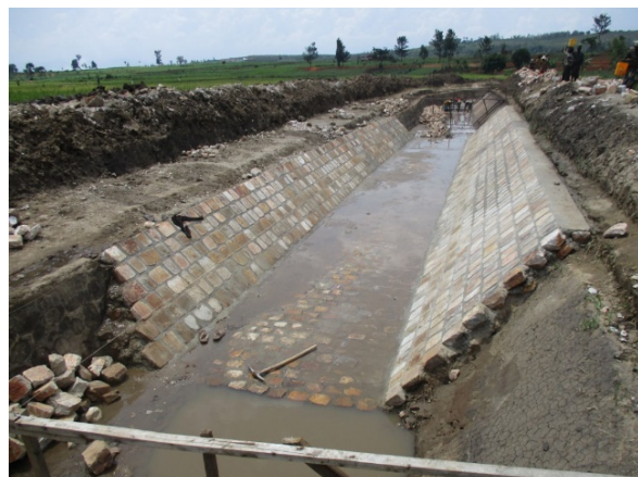
Photo 2 : Canal primaire C1/lot 1 – revêtement en maçonnerie de moellons
