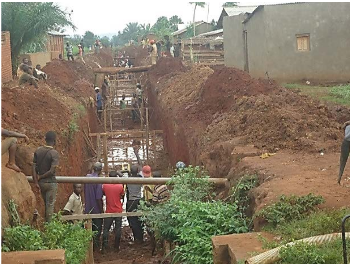
Photo 1 : Démarrage des travaux sur le lot 3 du périmètre Imbo, illustrant la nécessité de concertation avec les populations riveraines pour l'accès aux terrains pour les travaux d'aménagement
