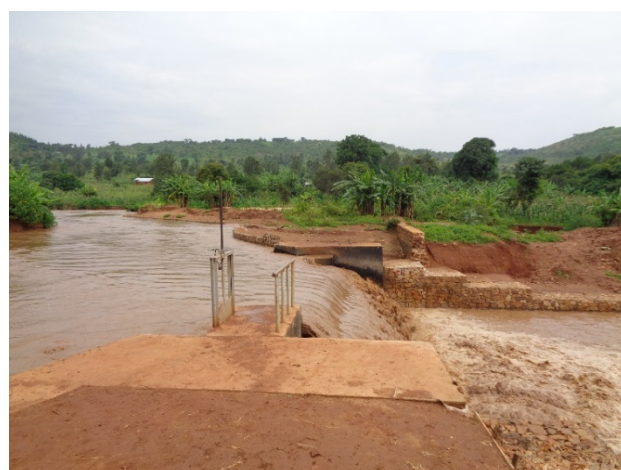
Photo 7 : Mise en eau du barrage Musasa 3
