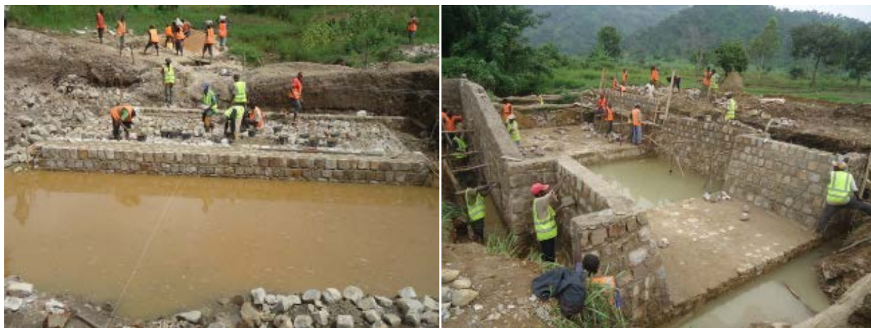
Photos 4 et 5 : Construction d'une prise sur émissaire, Ntanga amont
