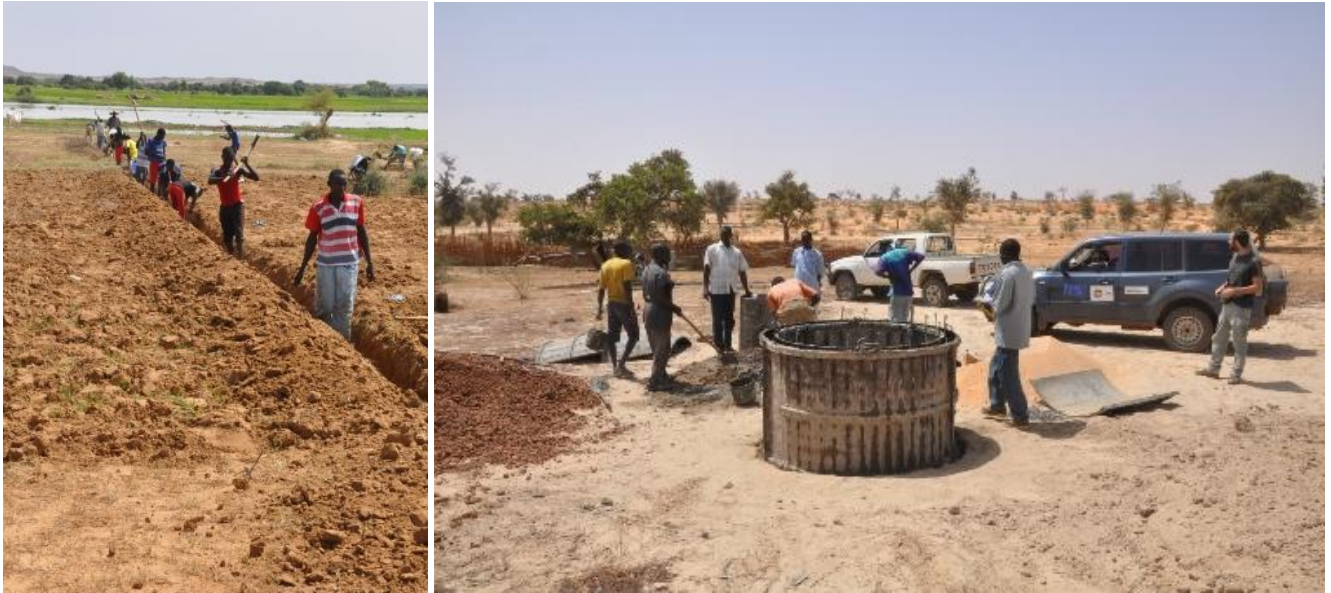
Réalisation des travaux d'aménagement
