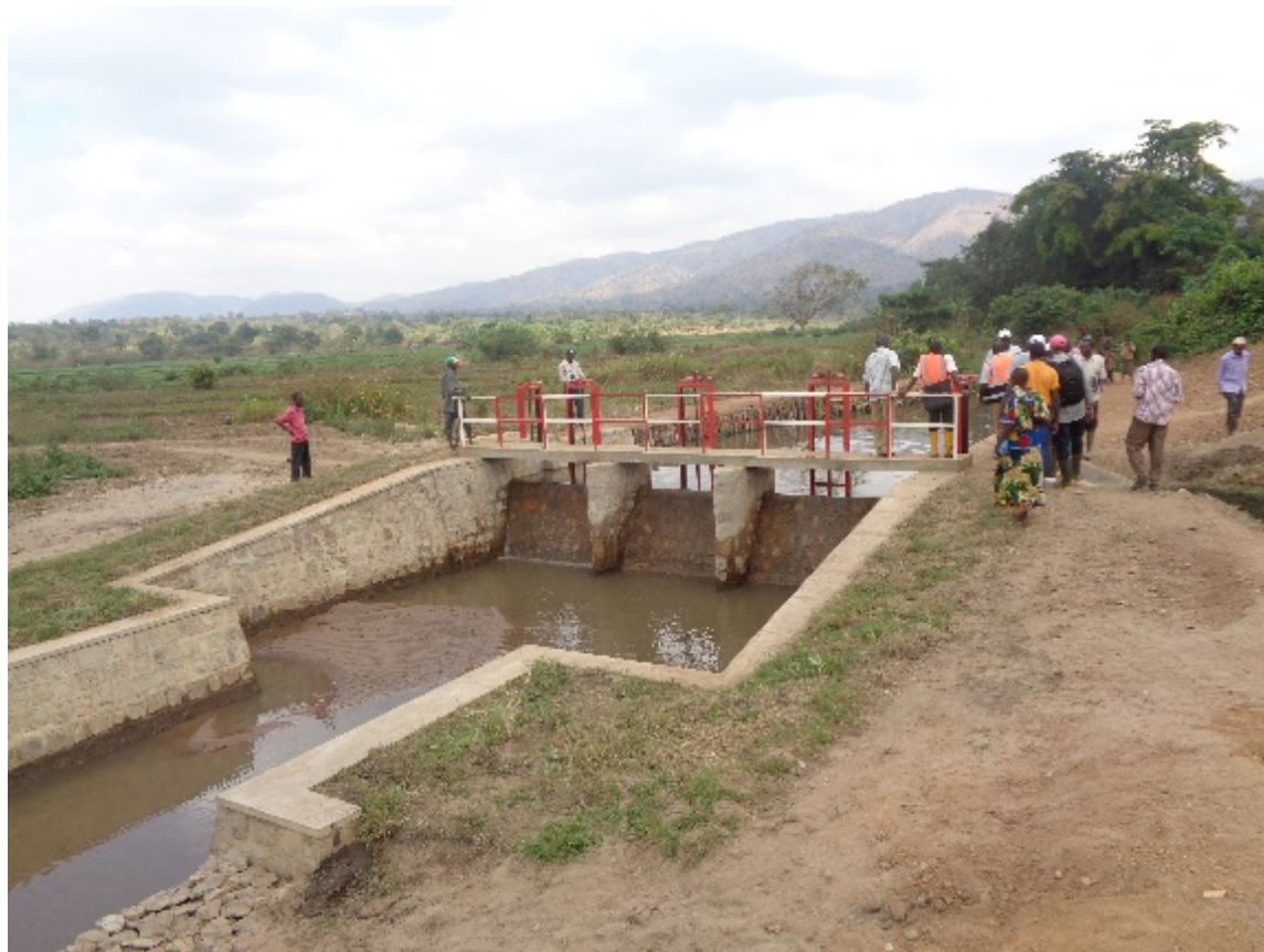
Photo 2 : Ouvrage de prise d'eau dans le marais de Ntanga Amont
