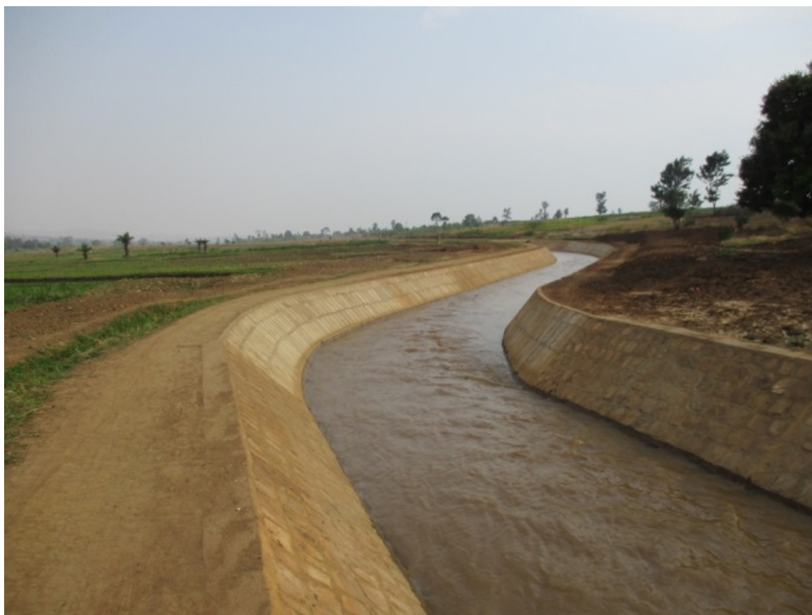
Photo 1 : Canal principal du périmètre Imbo Nord, après aménagement
