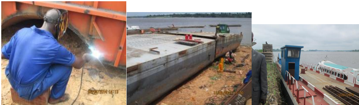
Figure 1 Les travaux en cours pour le nouveau bac de Yatolema( rivière Iobaie)
