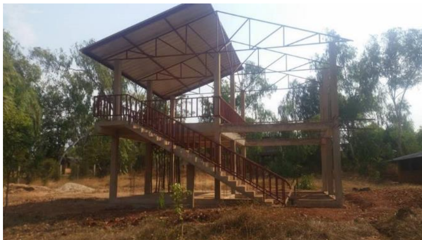
Photo : Une structure didactique prête aux travaux pratiques de formation - construction par les apprenants CEM
