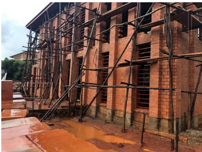
Photo : CRM en construction à Mugutu
