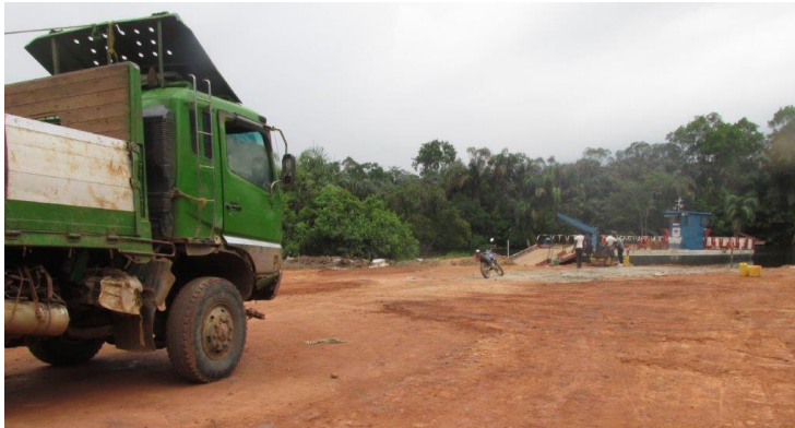
Photo : Accès du bac Yatolema après les travaux d'aménagement (2020)
