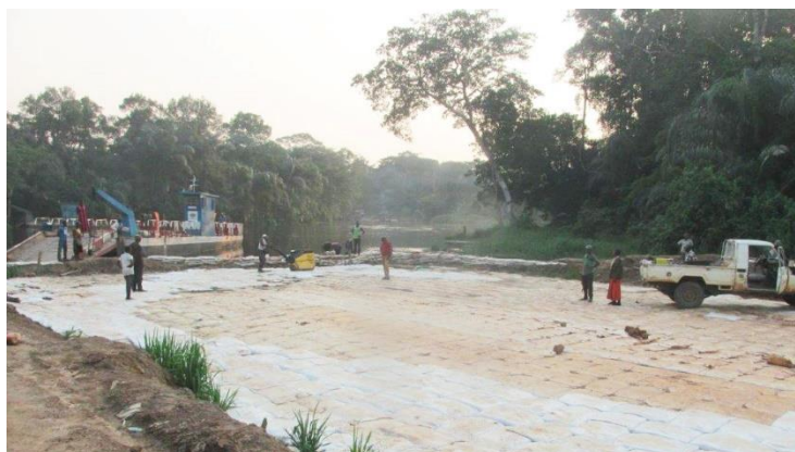
Photo : Aménagement des accès du bac Yatolema, rivière Lobaie rive droite (2019)
