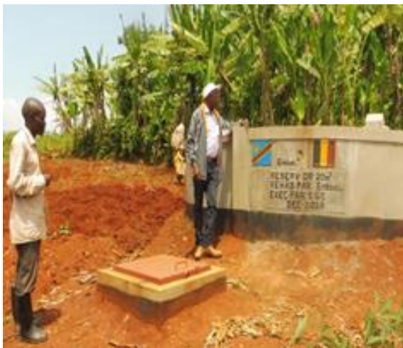
Réservoir 20 m 3 du réseau Nduba
