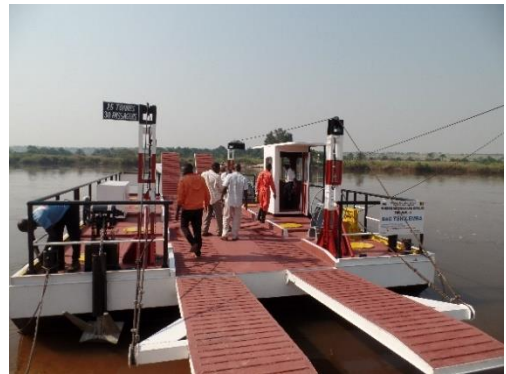
Bac Tshilemba (Kaponji), construction neuve
