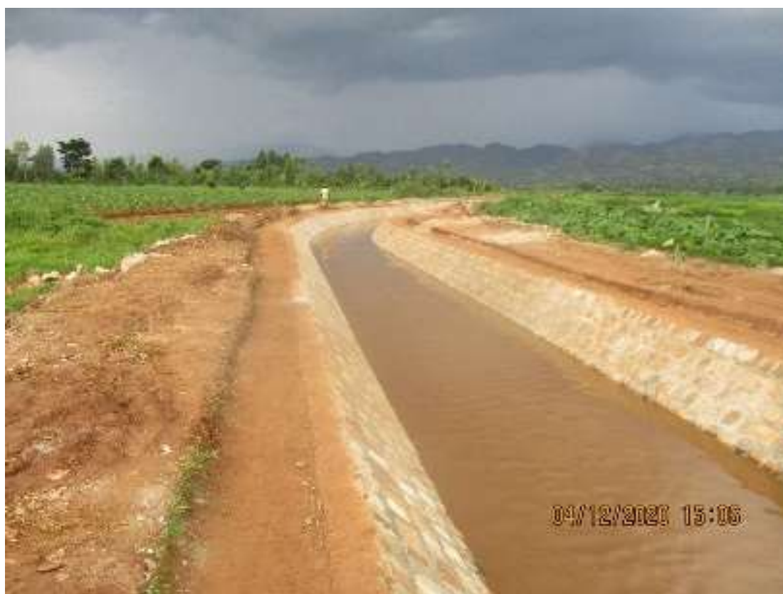
Photo 1 : Canal principal revêtu du périmètre Imbo Nord
