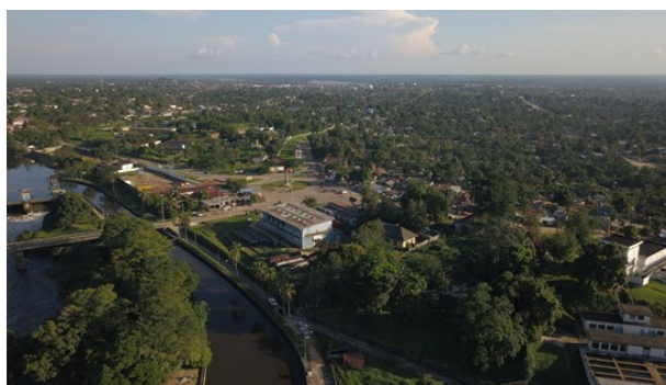
Canal d'aménagé et Centrale thermique Tshopo
