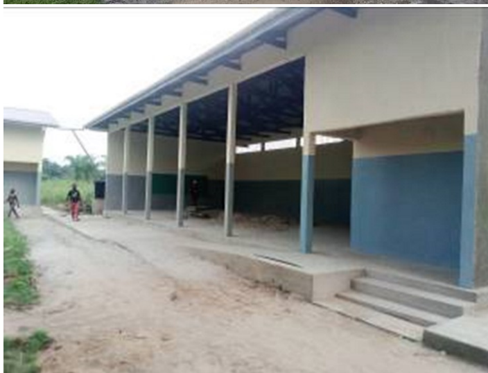
Travaux finalisés : 3 salles de classe, 2 Ateliers (Menuiserie et maçonnerie) et un Bloc sanitaires en 2020
