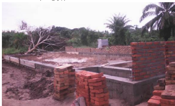
Démarrage des travaux
