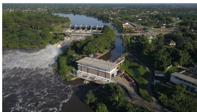
Barrage et Centrale hydroélectrique Tshopo – capture d'images avec un drone
