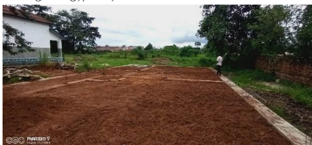
Démarrage des travaux 2019
