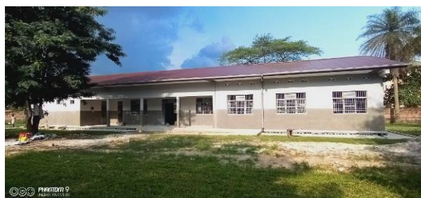
Travaux finalisés en 2020 : 1 Salle informatique, un atelier de couture et une boutique pour vêtement
