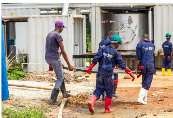
Jeunes maçons et mécaniciens installant une huilerie à la SCIPEC
