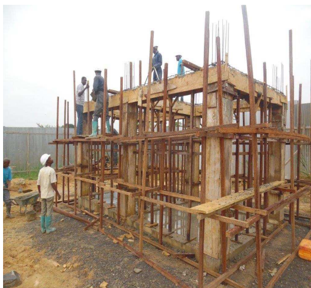
Bétonnage des poutres au château d'eau de Kabasoga
