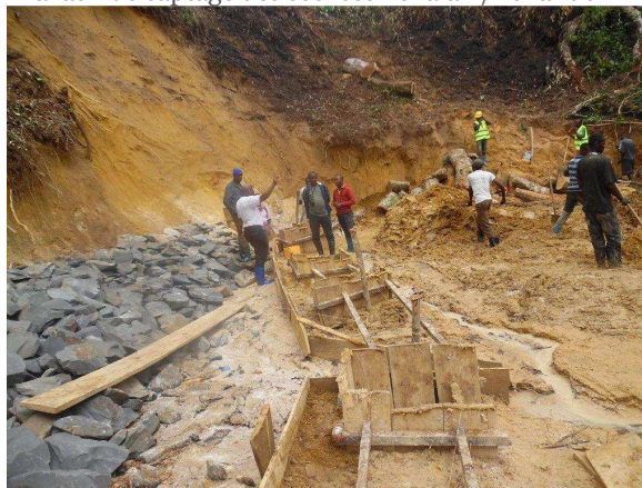
Travaux de captage des sources Tshala 2/Lokando
