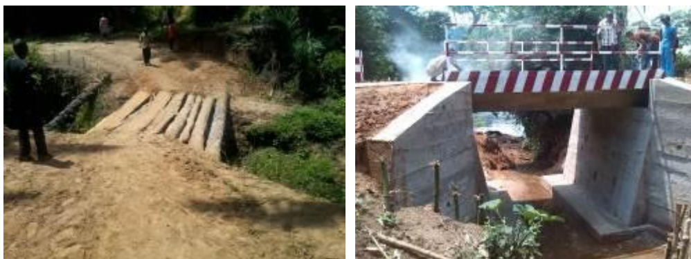
Ancien Pont vs nouveau Pont Mazamba (5ml) sur l'axe Kenge II / Tshakala-Mbewa (2015)
