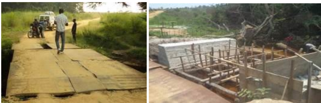
Pont Mbwakwom avant réhabilitation et pendant la réhabilitation (2015)
