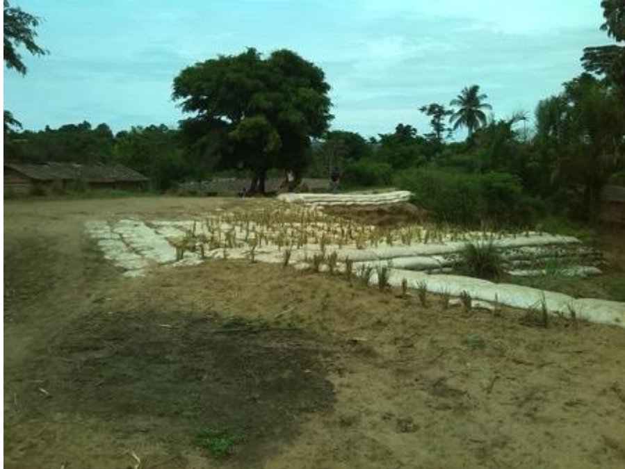
Érosion sur l'axe Kenge / Kenge II (2015), situation après plantation de vétiver (2015)
