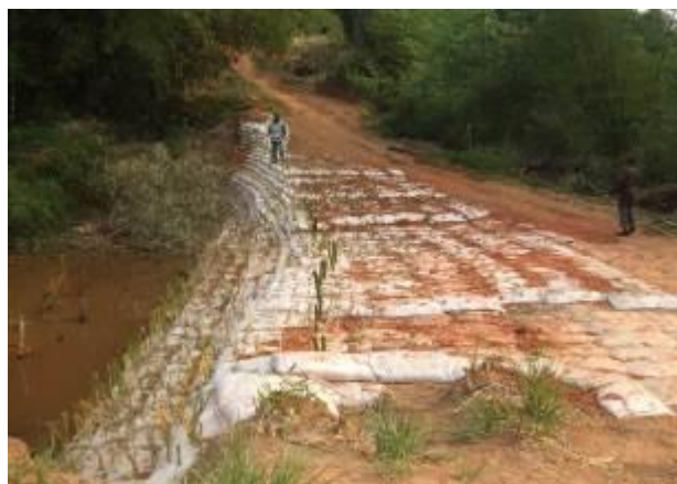
Reconstruction de la digue d'accès du Pont Yungu, territoire de Kenge (2015)
