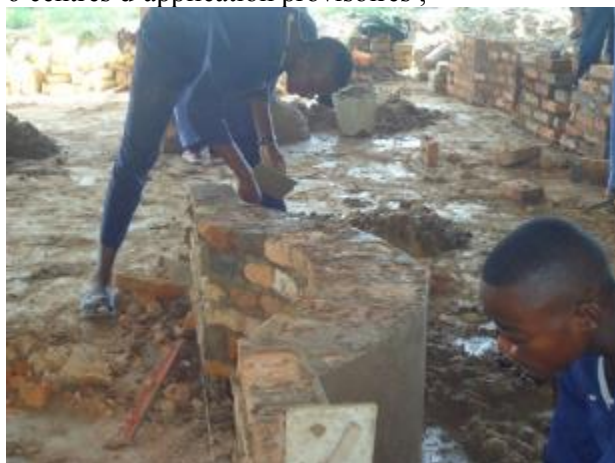
Apprenants lors des cours pratiques de maçonnerie à l'ITI CHOLOLO
