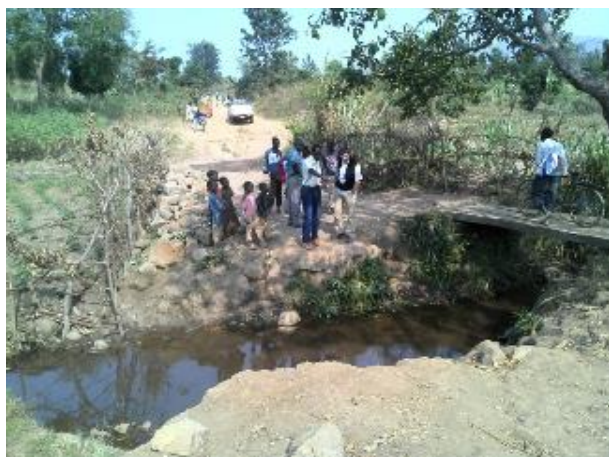
Photo 8 : Pont Mago (avant)
