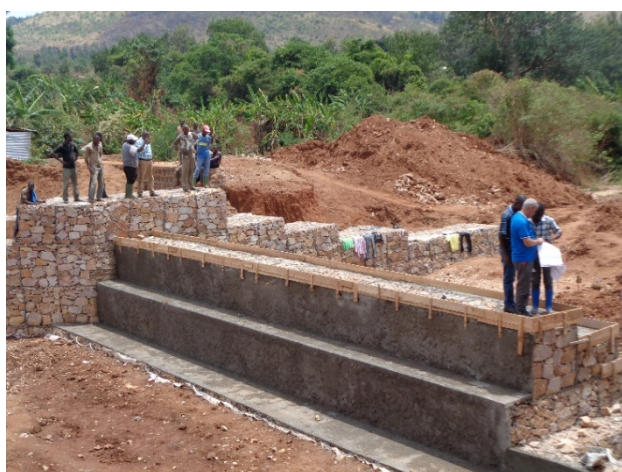
Photo 6 : Barrage Musasa 3 en réhabilitation
