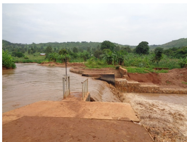
Photo 7 : Mise en eau du barrage Musasa 3
