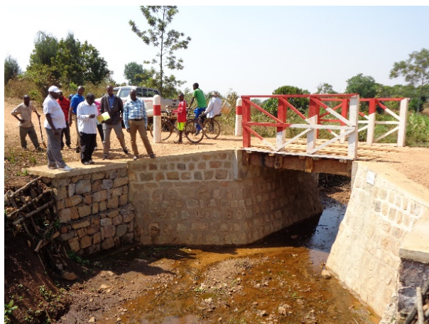
Photo 9 : Pont Mago (après)
