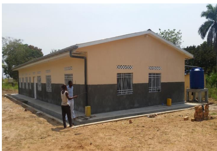
Figure 4: Bâtiment administratif de la PROVED MONGALA Réhabilité
