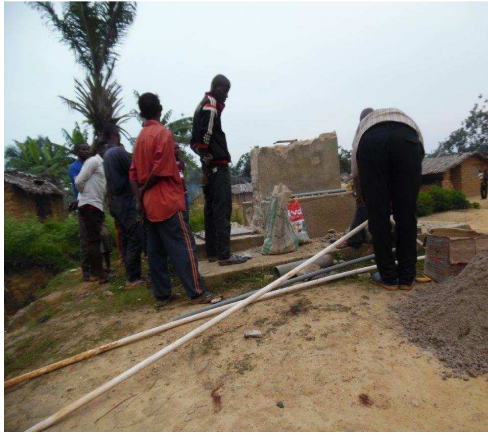
Travaux de réhabilitation d'une BF à Kailo
