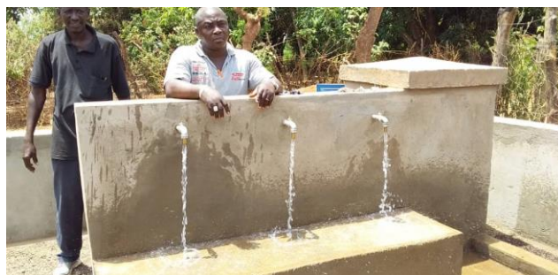
Réception technique de réseau à Bouliwel
