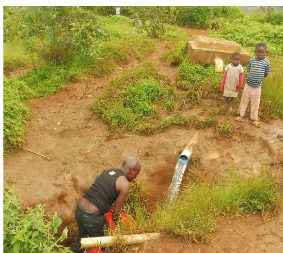
Mesure de débit du trop-plein citerne de 30m 3 Mwendo
