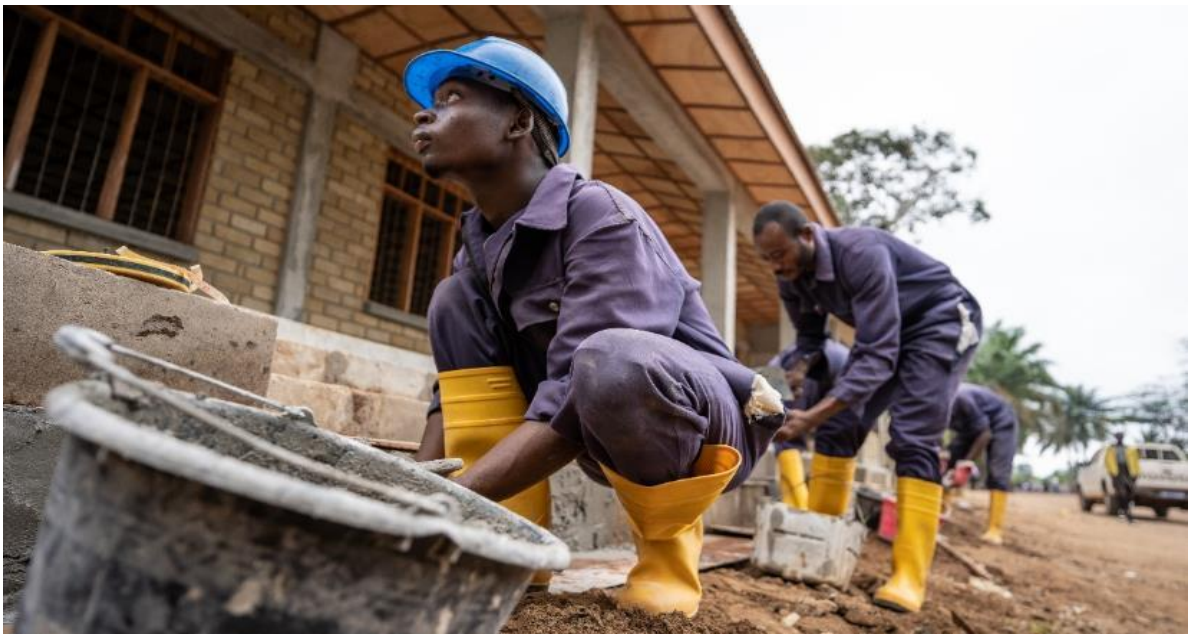
Jeune en insertion au chantier Ecole Budjala.
