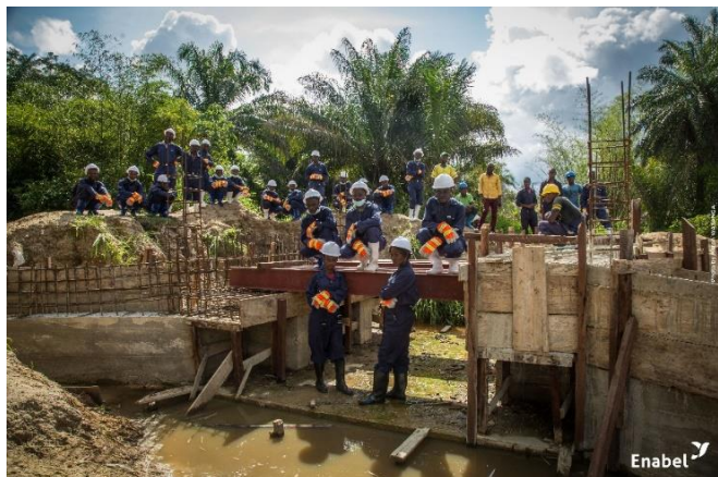
Jeunes stagiaires en chantier-écoles PRODAT-EDUT à Yanonge
