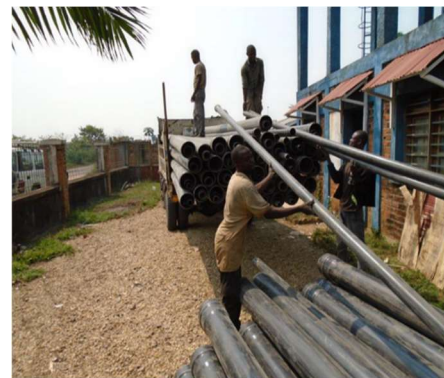
- Transports des conduites de la gare au CE
