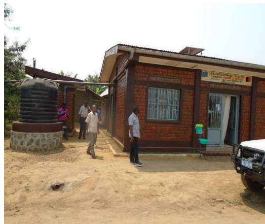
Système de collecte des eaux de pluie à l'ASUREP RVA
