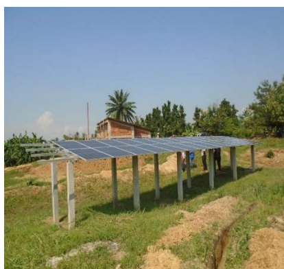
Montage du champ solaire de Basoko
