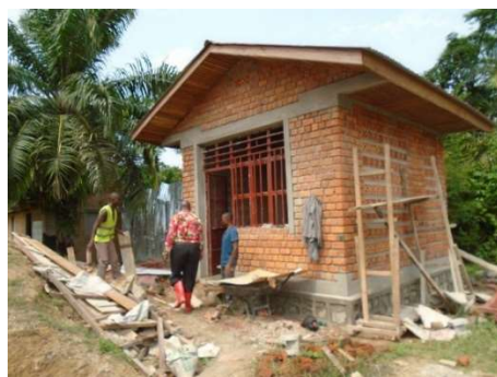
Travaux de finition sur le local à la station de pompage de Big five
