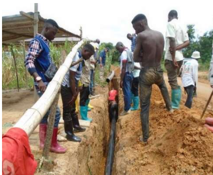
Pose des conduites PVC à joint Ø 200 refoulement réseau Big five de Basoko
