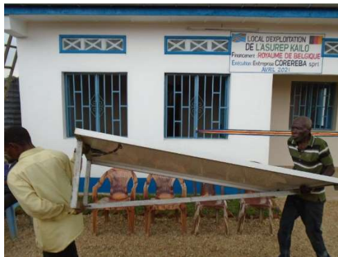
Montage du Kit solaire sur le bâtiment l'ASUREP Kailo
