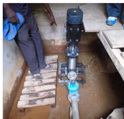
Nouvelle pompe solaire de Kailo déjà montée & opérationnelle sur GE
