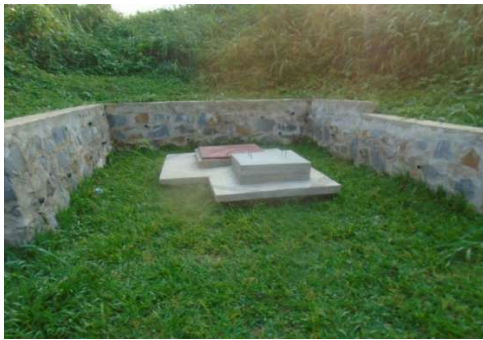
Captage sécurisé à Kabasoga 1
