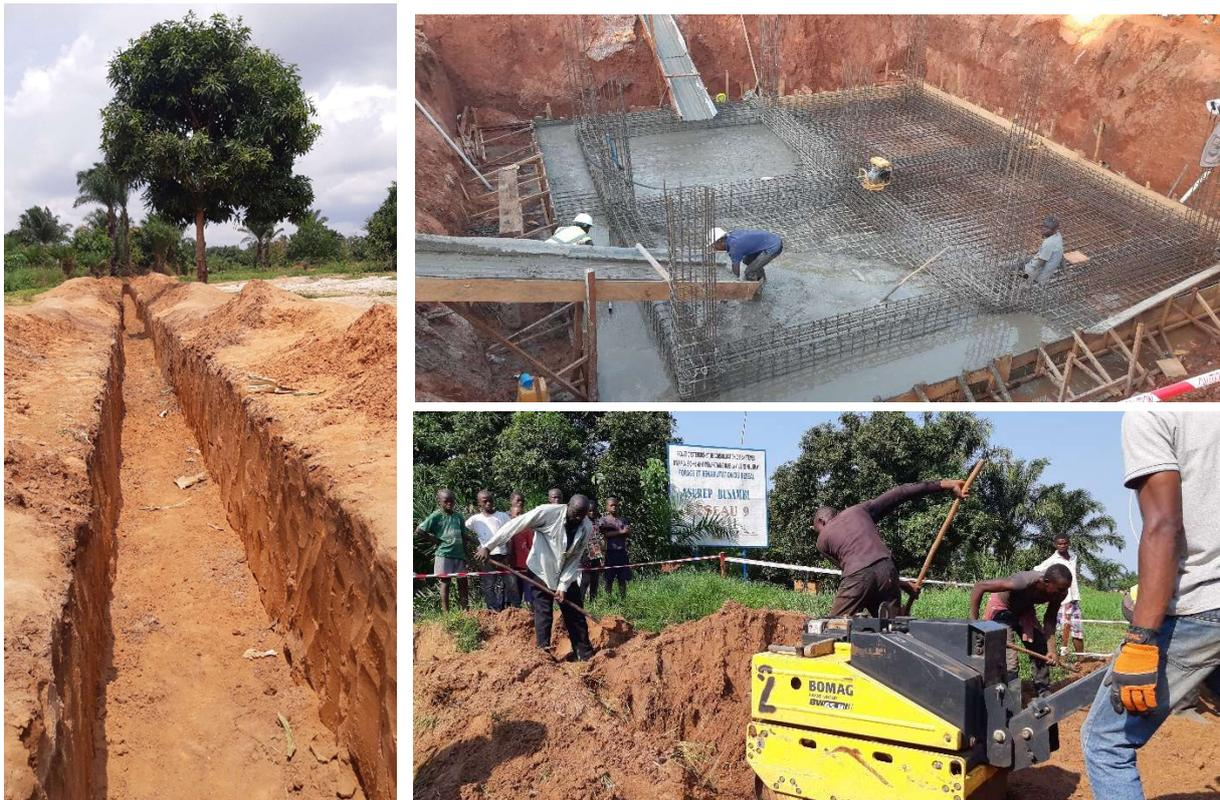
**Fouilles des tranchées, remblayage et construction des ouvrages de génie civil**
