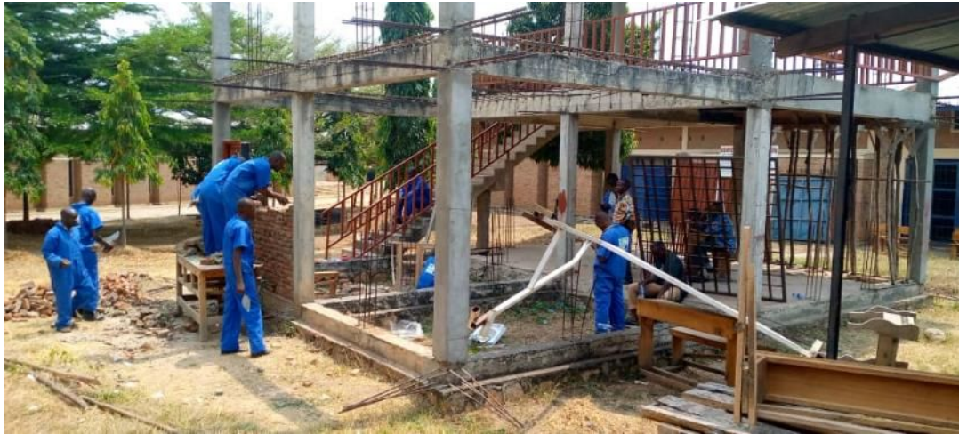
Photo : formation des formateurs des filières inter-métiers du BTP au CFP Kanyosha
