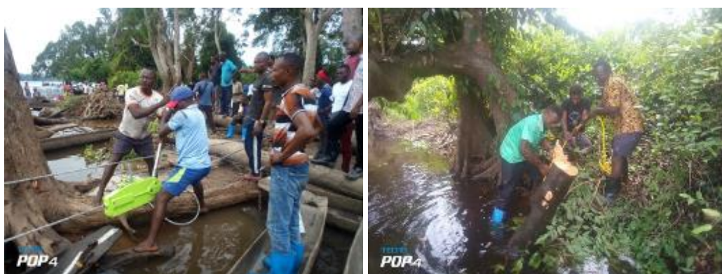
Travaux de desnagage sur la rivière LOMAMI (ASTRABIS et OVDA).
