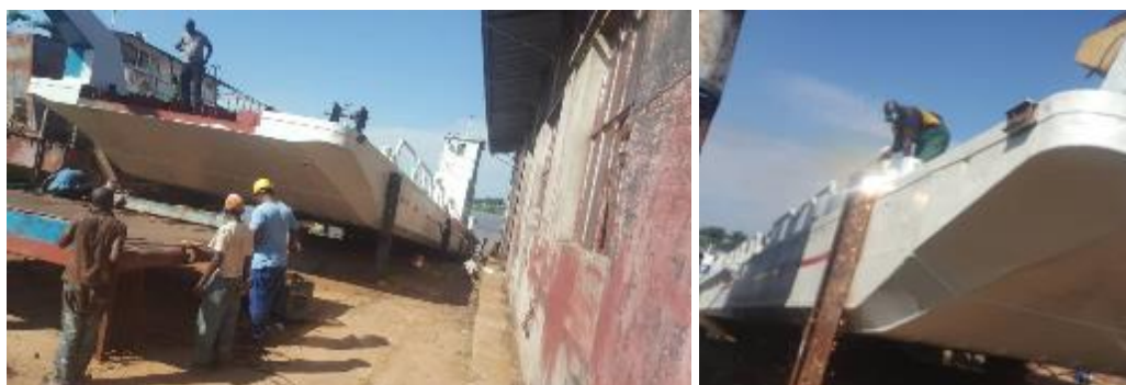
Réhabilitation du bac Kisangani III
