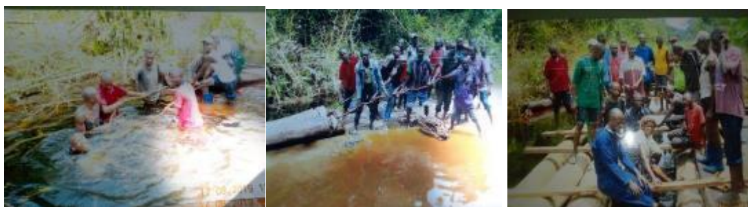
Construction d'un pont en bois par une dynamique locale.
