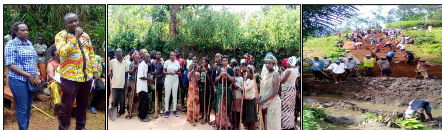
Initiative communautaire. Restauration d'un pont dans la province Cibitoke. Présence du chef de zone pour l'ouverture des travaux qui ont été fait en plusieurs étapes pour connecter des communautés de Rugendo, Rusagara et Kirinzi qui étaient antagonistes avant les dialogues communautaires.
