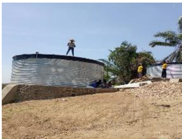
Figure 6: Finalisation de montage des 2 tanks de stockage d'eau, adduction de Ramogi
