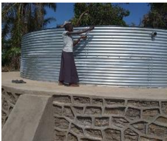
Figure 5: Montage tanks de l'Adduction d'eau de Ramogi, femme du COGEP y participe.
