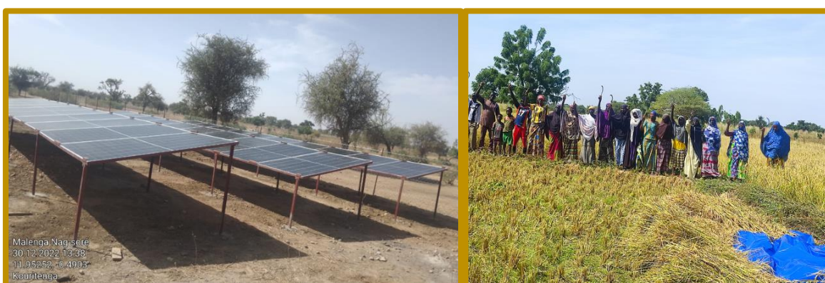
Installation d'un champ photovoltaïque pour le périmètre irrigué Récolte du riz dans le bas-fond de Kougré de Malanga-Nagsoré
