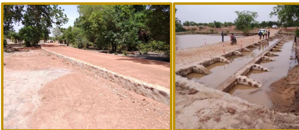
Tronçon de piste en HIMO Gomsin-Kombilga Tronçon de piste en radier seuil Tounougou Toné- Cinkansé
