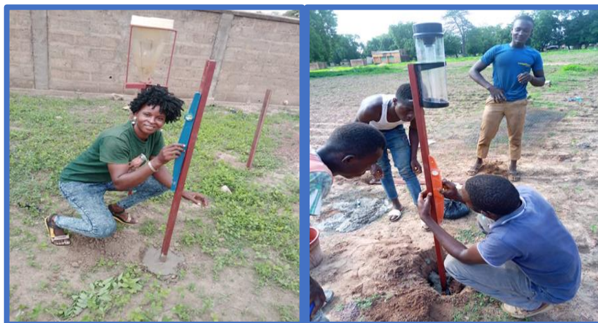
Installation des pluviomètres par les agents de la DRAAHM dans une commune. Crédit photo, DRAAHM.
