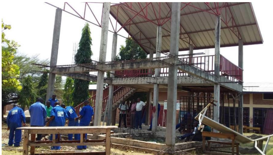
Photo no. 1 : Formation des formateurs sur la structure didactique inter-métiers du BTP au CFP Kanyosha
