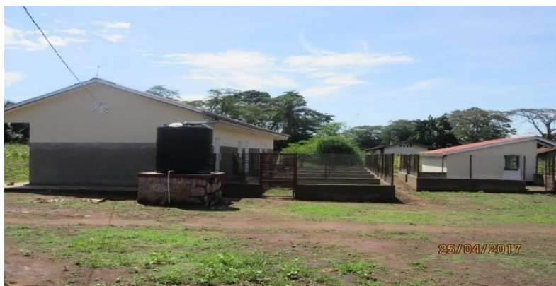
Photo 12 : Poulaiers construit par EDUKOR pour la filière vétérinaire
