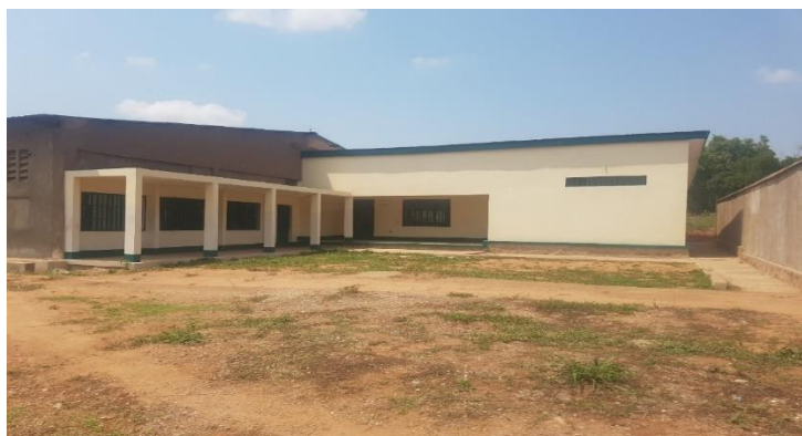
Photo 8 : Infrastructure construite par EDUKOR qui abritera avec l'installation des équipements l'atelier didactique de mécanique moto », laboratoire NTIC, bibliothèque
