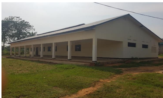
Photo 4 : Infrastructure réhabilitée par EDUKOR qui abritera avec l'installation des équipements l'atelier de Transformation Alimentaire
