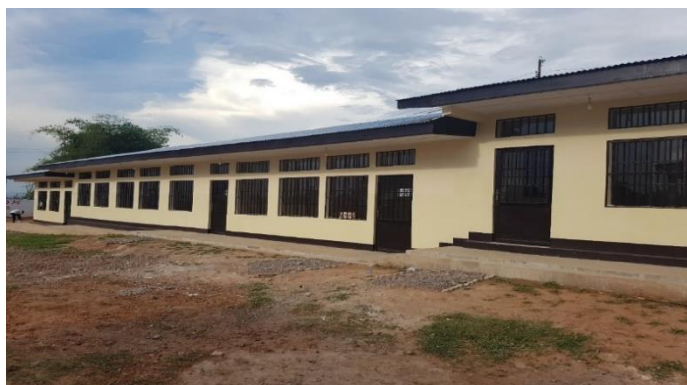
Photo 6 : Infrastructure construite par EDUKOR qui abritera avec l'installation des équipements et mobilier les salles de cours, laboratoire NTIC, bibliothèque
