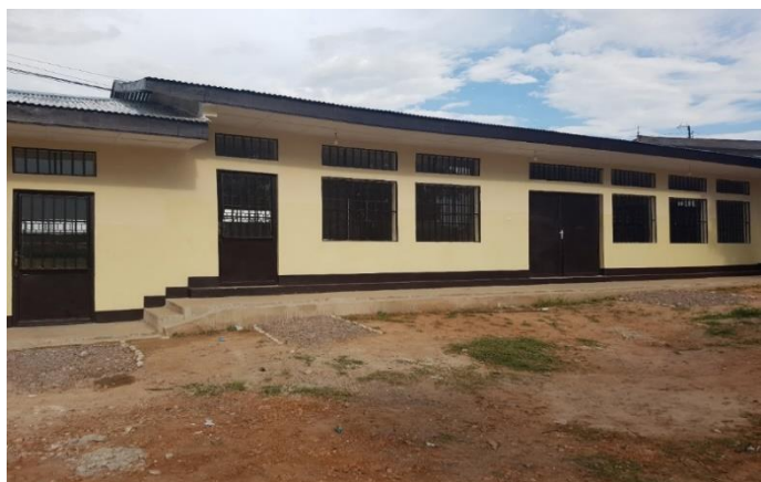
Photo 7 : Infrastructure construite par EDUKOR qui abritera avec l'installation des équipements/outillage l'atelier de pratique menuiserie
