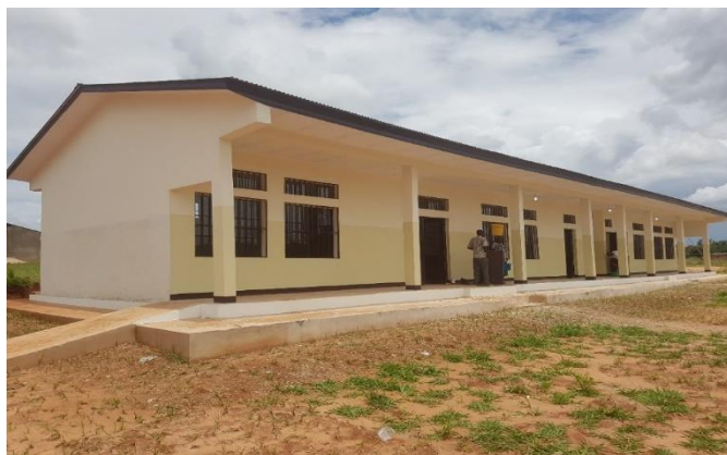
Photo 2 : Infrastructure construite par EDUKOR et qui abritera avec l'installation des équipements le laboratoire NTIC, U.F.E., bibliothèque et sanitaires
