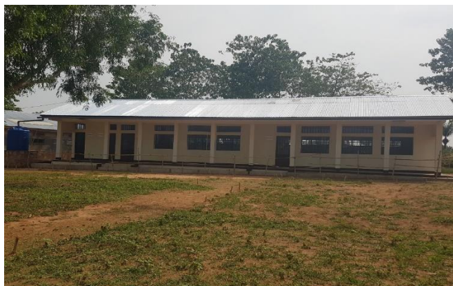
Photo 3 : Infrastructure construite par EDUKOR qui abritera avec l'installation des équipements, le laboratoire NTIC, UFE., bibliothèque et sanitaires
