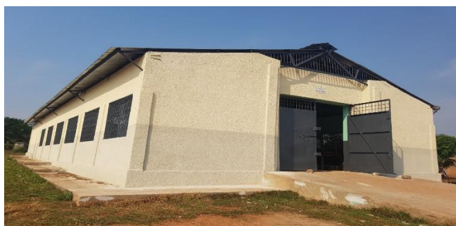
Photo 1 : Atelier réhabilité par EDUKOR qui abritera les équipements pour les cours pratique de « Mécanique Générale
