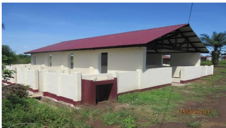
Photo 11 : Porcherie réhabilitée par EDUKOR pour la filière vétérinaire
