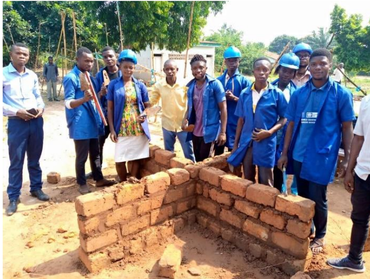
Formation courte en construction à Makala
