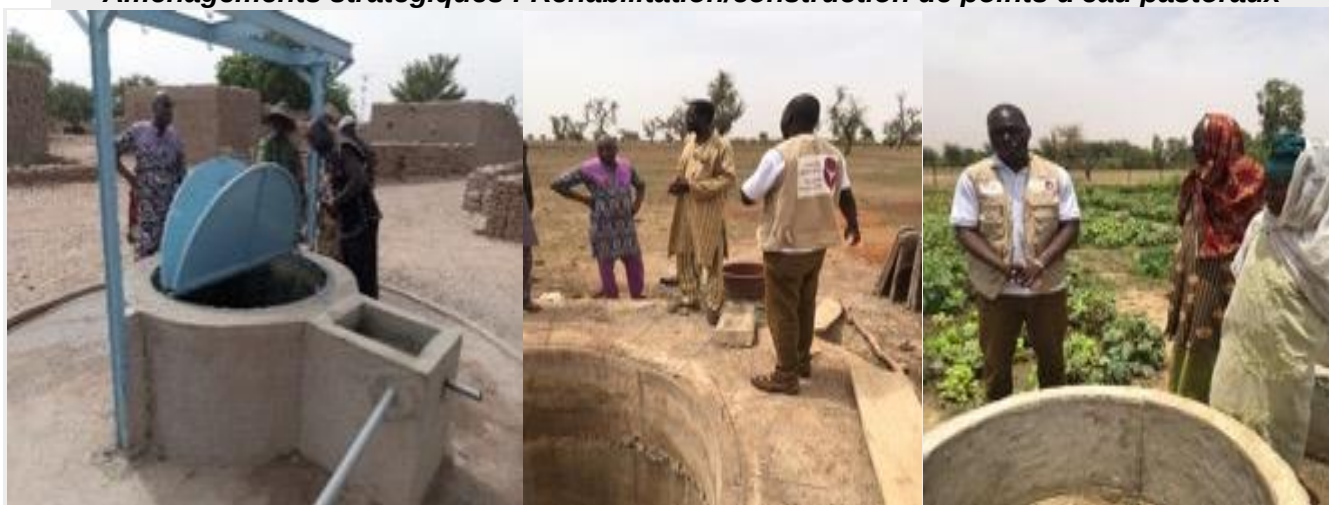
Aménagement de puit pastoral à Diabolo dans le village de Koundaraka (Cercle de Djenné)
