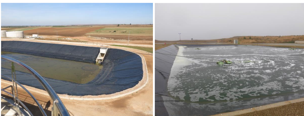
Bassins pour lagunage naturel et lagunage aéré
